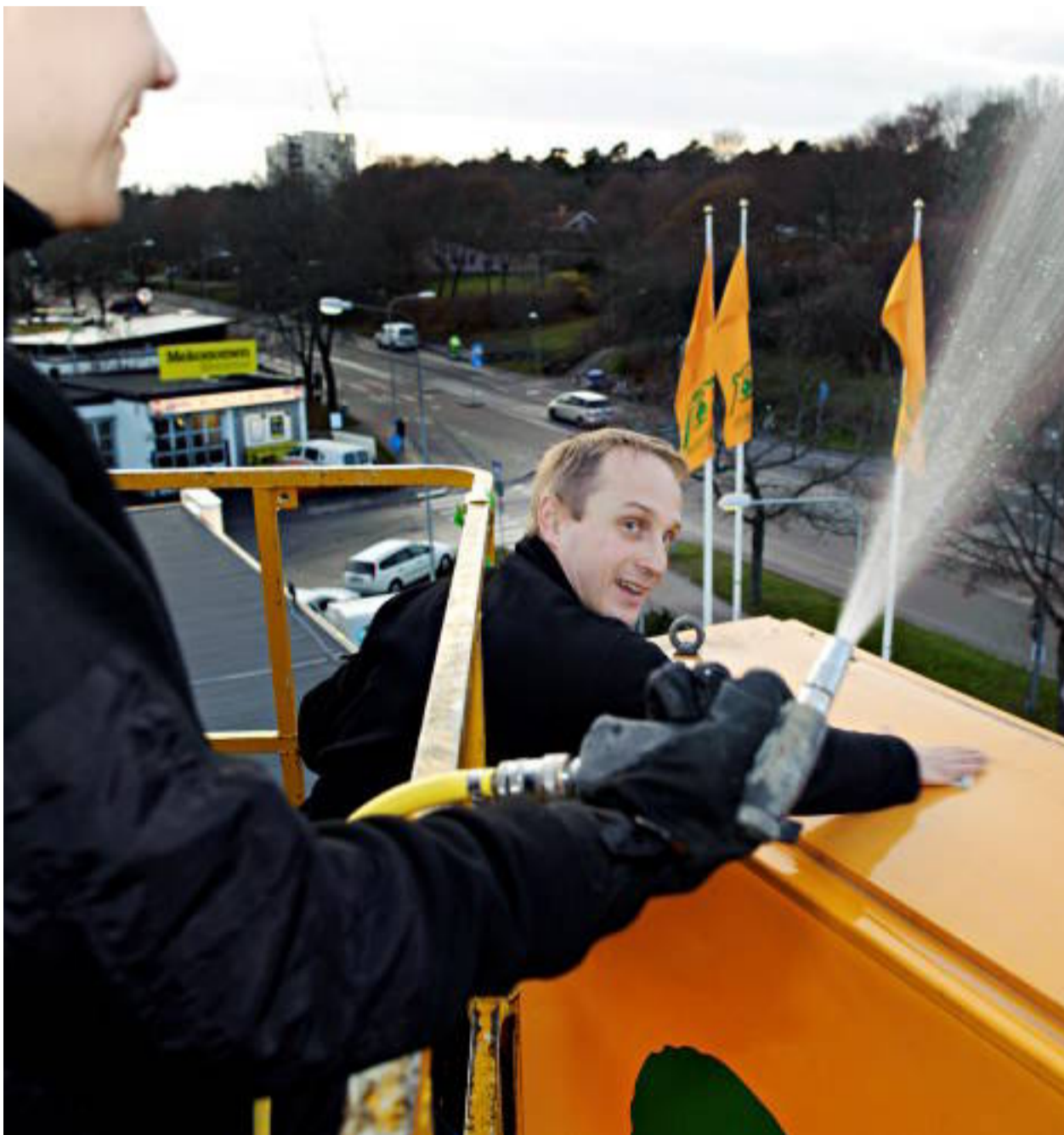
ULTRARENT. Tobias Olsson och Johan Eriksson på Ekofasad rengör fasader med så kallat ultrarent vatten. Kort sagt luras mögel och alger att dricka ihjäl sig.
